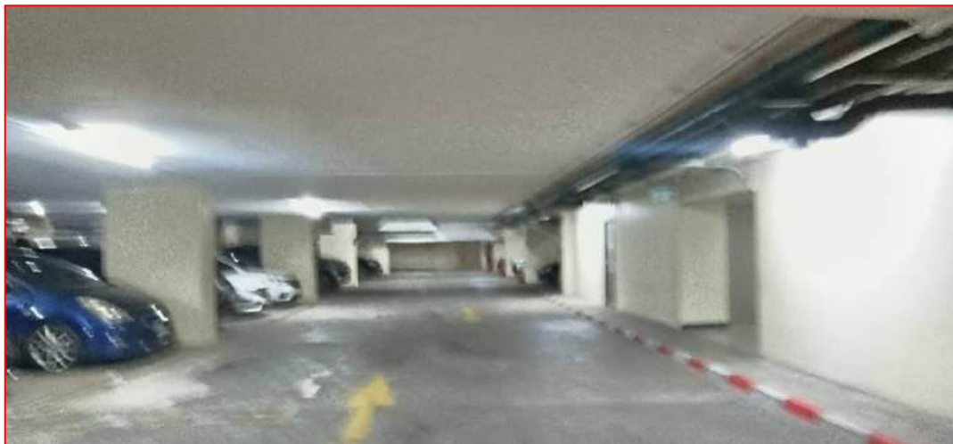
สภาพภายในอาคาร บริเวณที่จอดรถ ชั้นที่ 5
