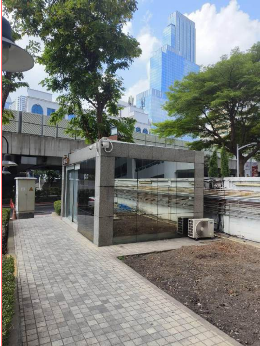
สภาพสภาพภายนอกอาคารสิ่งปลูกสร้างรายการที่ 2
